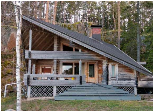
Kuivajääpuhalluksessa ei käytetä lainkaan vettä tai kemikaaleja. Menetelmä sopii hyvin erilaisten pintojen puhdistukseen.
