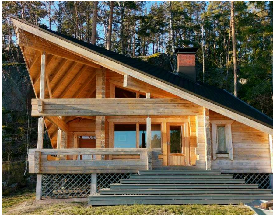
Kuivajääpuhalluksen avulla mökki herää aivan uudella tapaa eloon. Puhdistuksen jälkeen pintaan voidaan tehdä impregnointikäsittely, joka tekee puhdistetulle pinnalle suojakerroksen.
